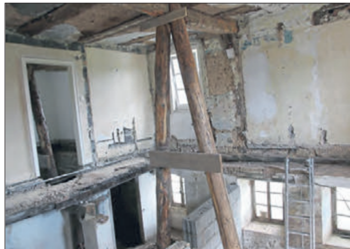
Zurückgebaut: Wo einst ein repräsentativer Saal eingebaut war, klafft nun ein Loch. Baumstämme sichern das Obergeschoss.
