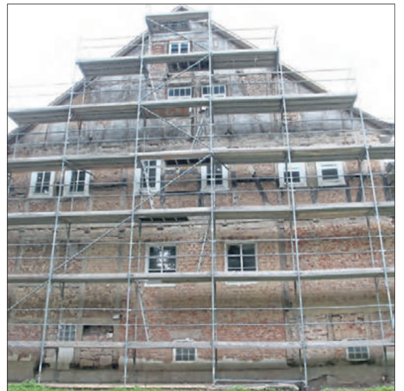
Der Putz ist ab: An der Westseite kann man die unterschiedlichen Baumaterialien deutlich sehen.
