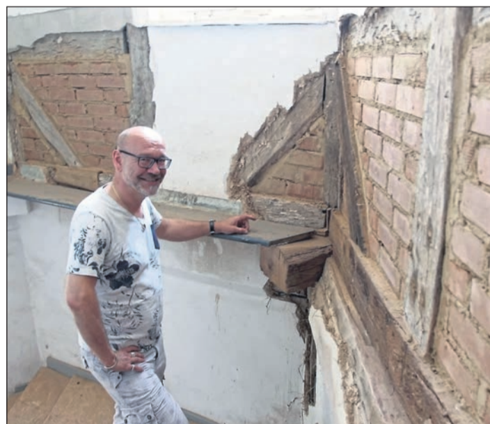
Im Turm: Bauherr Dieter Mergenthal zeigt, wo das verfaulte Holz ausgetauscht werden musste.
