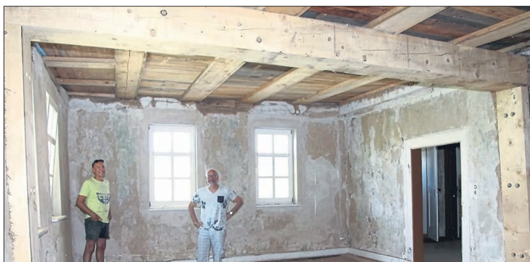
Jetzt wieder ein Saal: Dieter Mergenthal und sein Bruder Erik, der die Bauaufsicht ausübt, im komplett erneuerten großen Raum im Obergeschoss. Fehler beim Bau dieses Saales im 18. Jahrhundert hatten dazu geführt, dass das gesamte statische Gefüge der Burg nicht mehr gestimmt hatte. Zu Beginn der Sanierung musste die Rotenburger Zimmerei Hahn deshalb Stützbalken vom Keller bis zum Dach installieren – wie das kleine Archivbild rechts zeigt.
