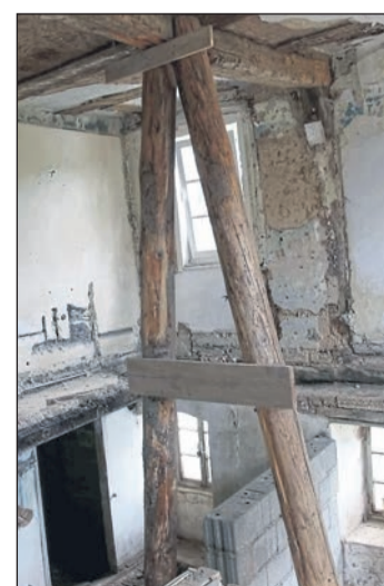
Jetzt wieder ein Saal: Dieter Mergenthal und sein Bruder Erik, der die Bauaufsicht ausübt, im komplett erneuerten großen Raum im Obergeschoss. Fehler beim Bau dieses Saales im 18. Jahrhundert hatten dazu geführt, dass das gesamte statische Gefüge der Burg nicht mehr gestimmt hatte. Zu Beginn der Sanierung musste die Rotenburger Zimmerei Hahn deshalb Stützbalken vom Keller bis zum Dach installieren – wie das kleine Archivbild rechts zeigt.
